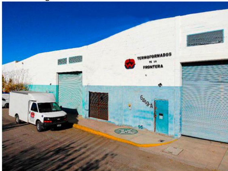
Figura 4. Termoformados de la frontera
